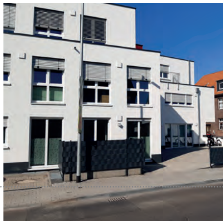
Der Karren-Neubau in Niederpleis
